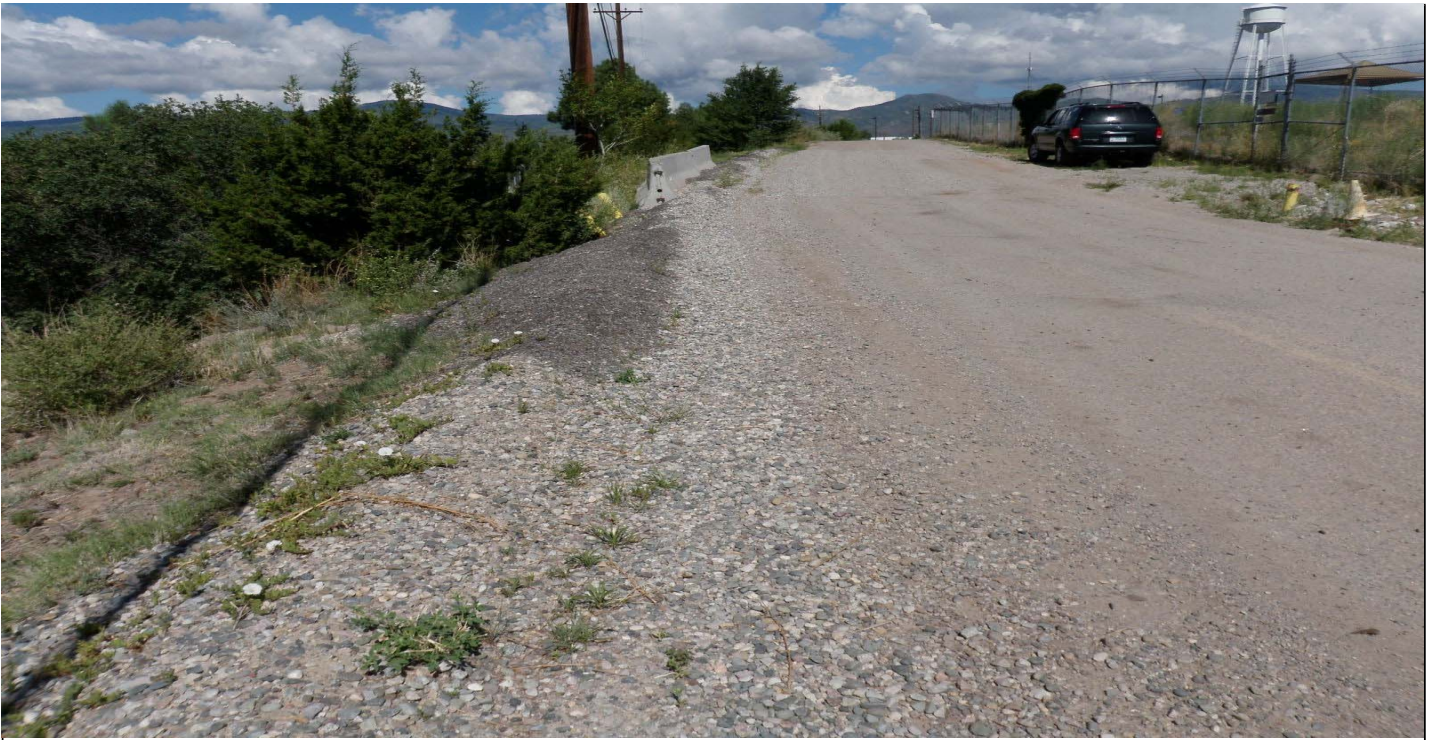
Photo 7431-2.JPG (taken 07/29/10) L022A03040002 : Berms - Asphalt Berm.
