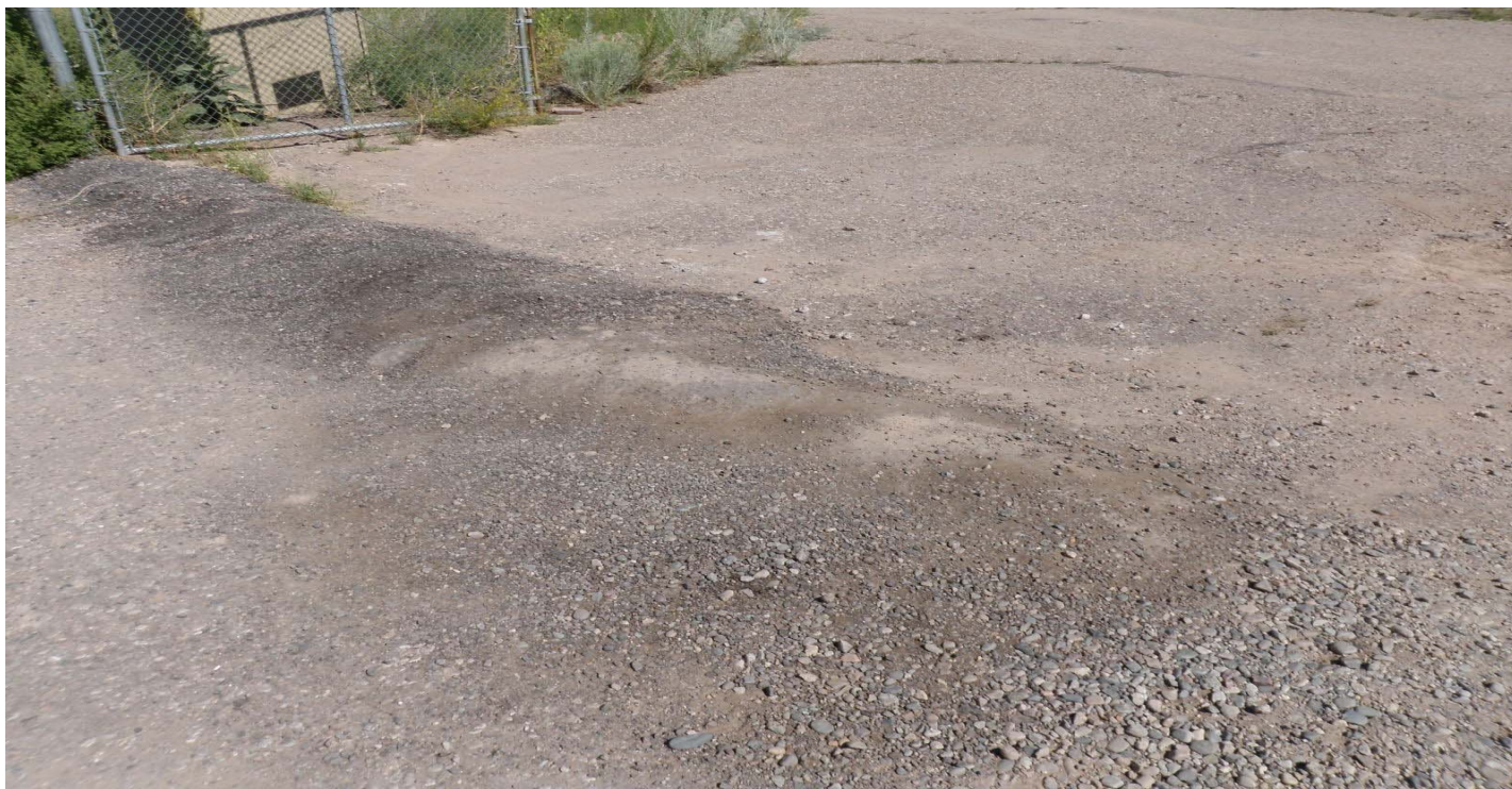
Photo 7433-2.JPG (taken 07/29/10) L02403040004 : Berms - Asphalt Berm.
