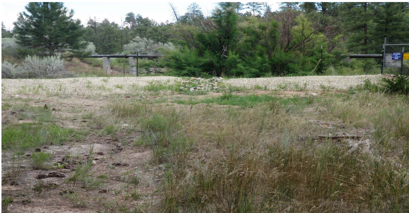
Photo 7452-9.JPG (taken 08/04/10) T00103010002 : Berms - Earthen Berm.
