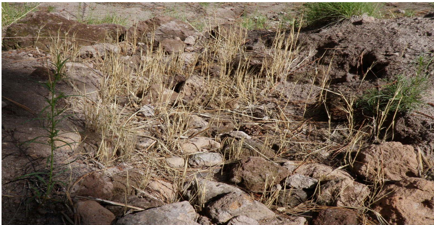
Photo 7425-2.JPG (taken 07/28/10) L01204060006 : Channel/Swale - Rip Rap.
