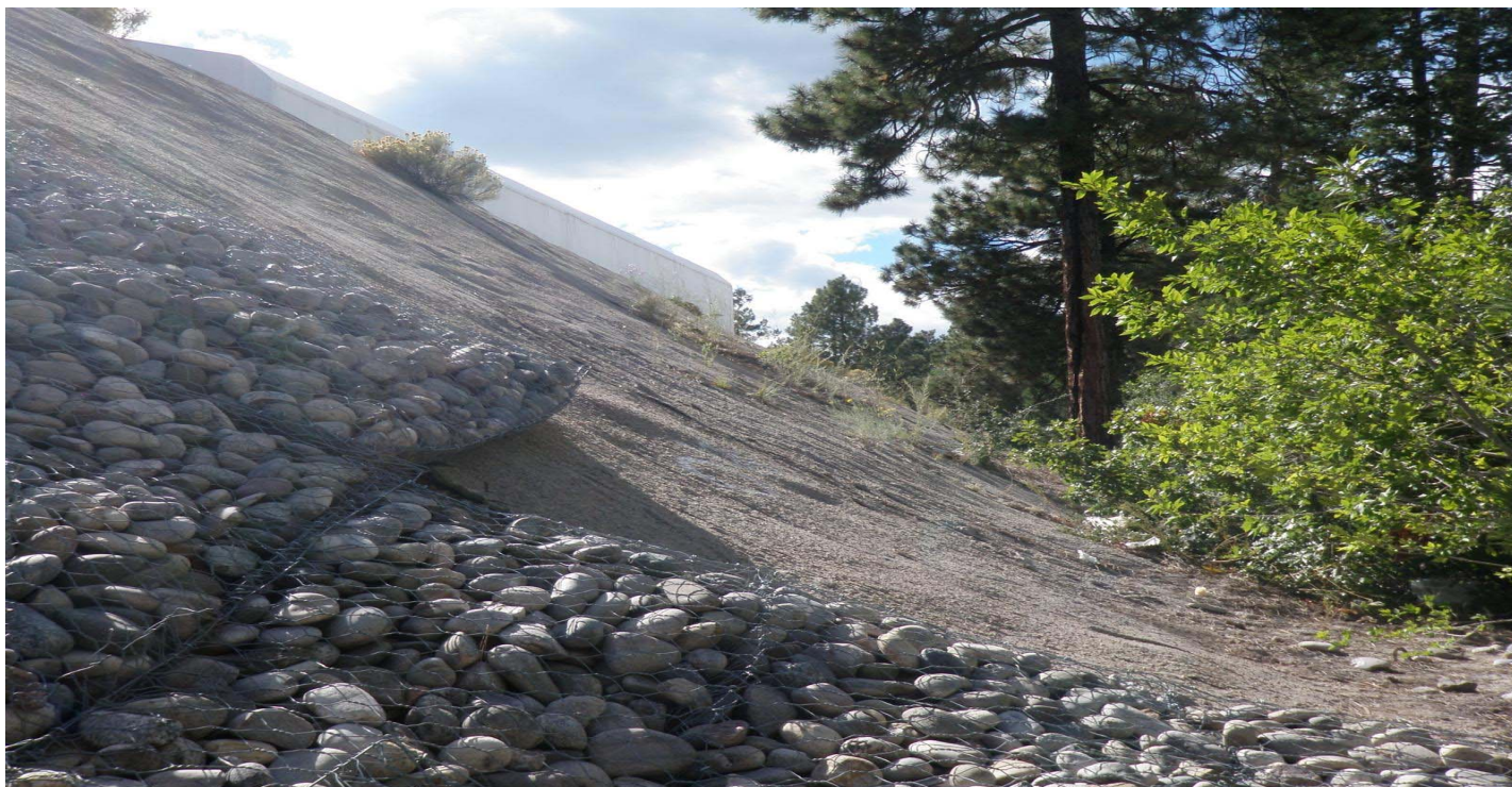
Photo 10550-01r.JPG (taken 09/20/10) M00808030002 : Cap - Concrete/Asphalt Cap.
