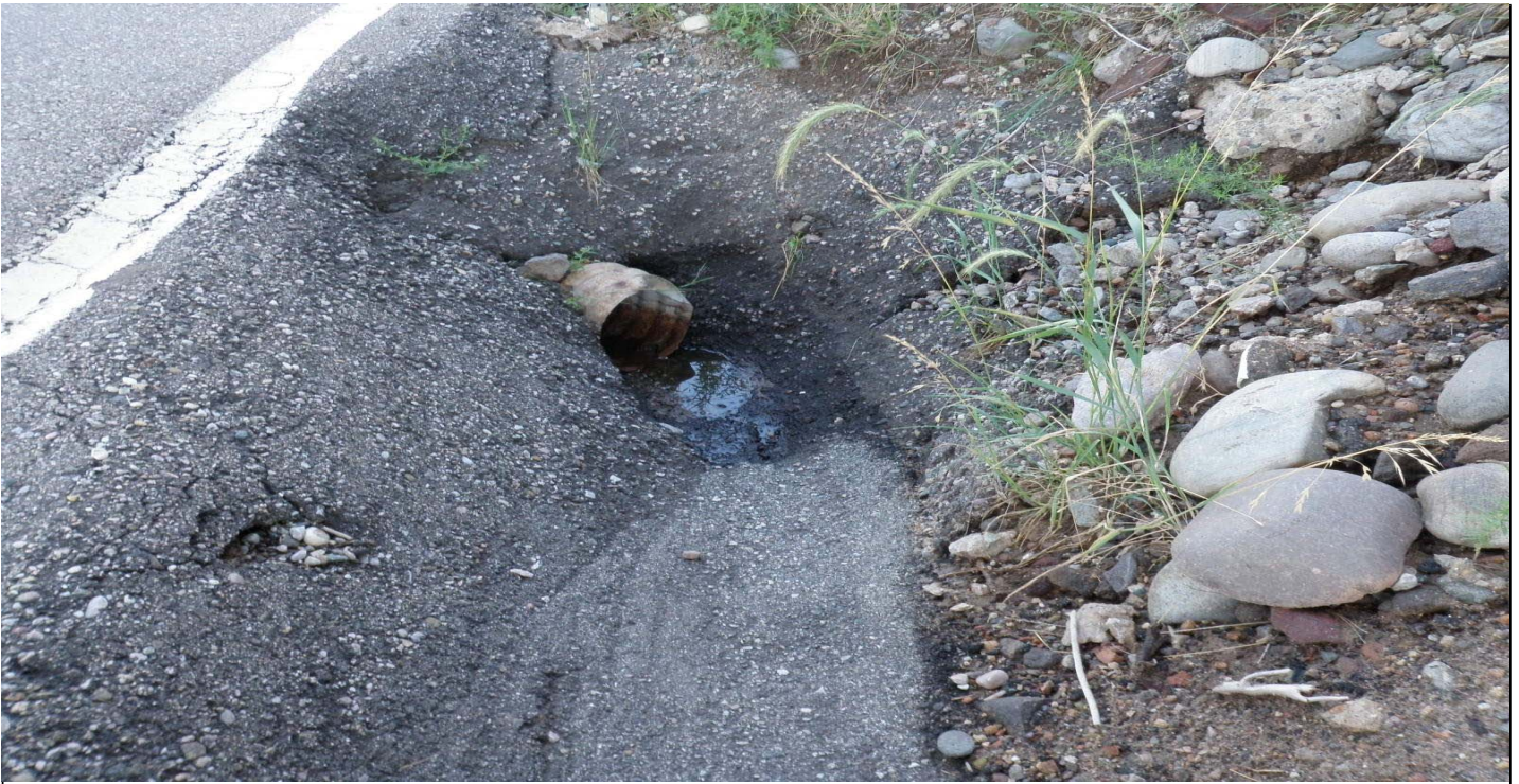
Photo 7418-2.JPG (taken 07/28/10) L00304040004 : Channel/Swale - Culvert.
