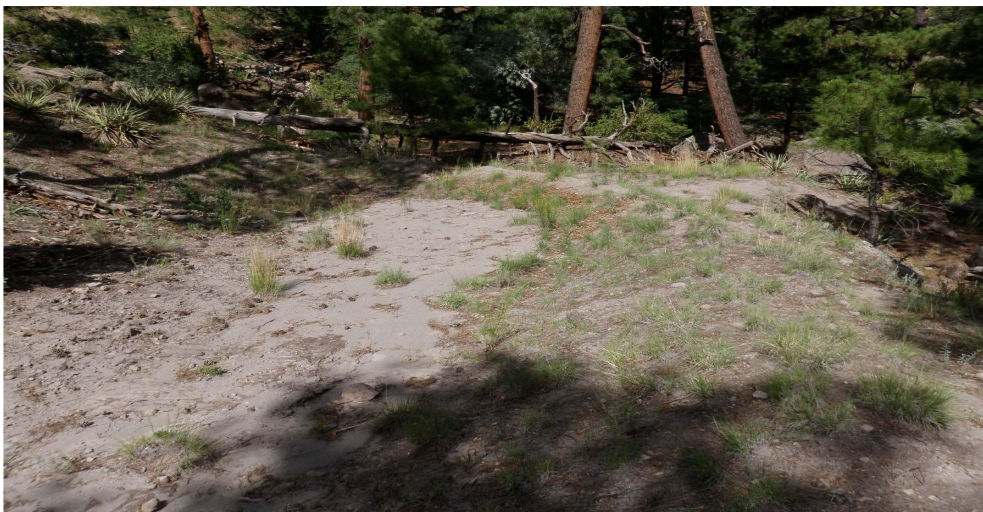
Photo 7425-1.JPG (taken 07/28/10) L01203010004 : Berms - Earthen Berm.
