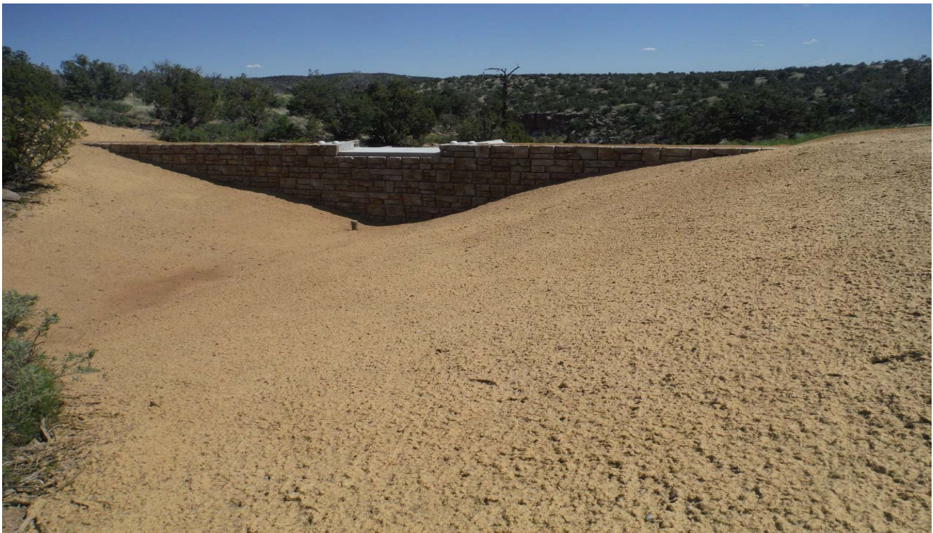
Photo: 46213-26.JPG Q00903150043 Berms
