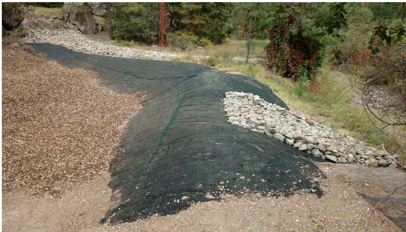
Photo: 50641-4.jpg L018A03010009 Berms
